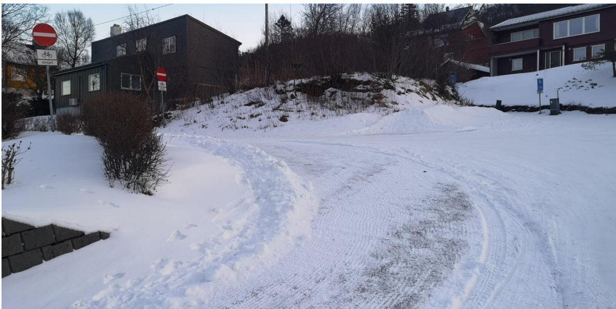
Figure 9: Siktforhold og svingradier i vegkryssene er viktig for trafikksikkerheten. På bildet sees krysset mellom Bakkegata og Prestmarkveien.
